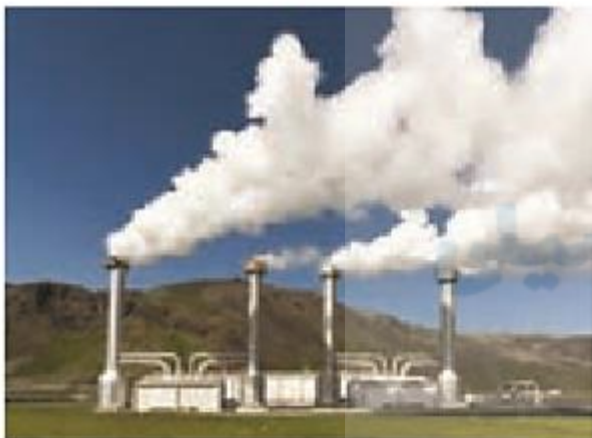
شکل ۱۱-۶- نیروگاه زمین گرمایی مشکین شهر اردبیل
